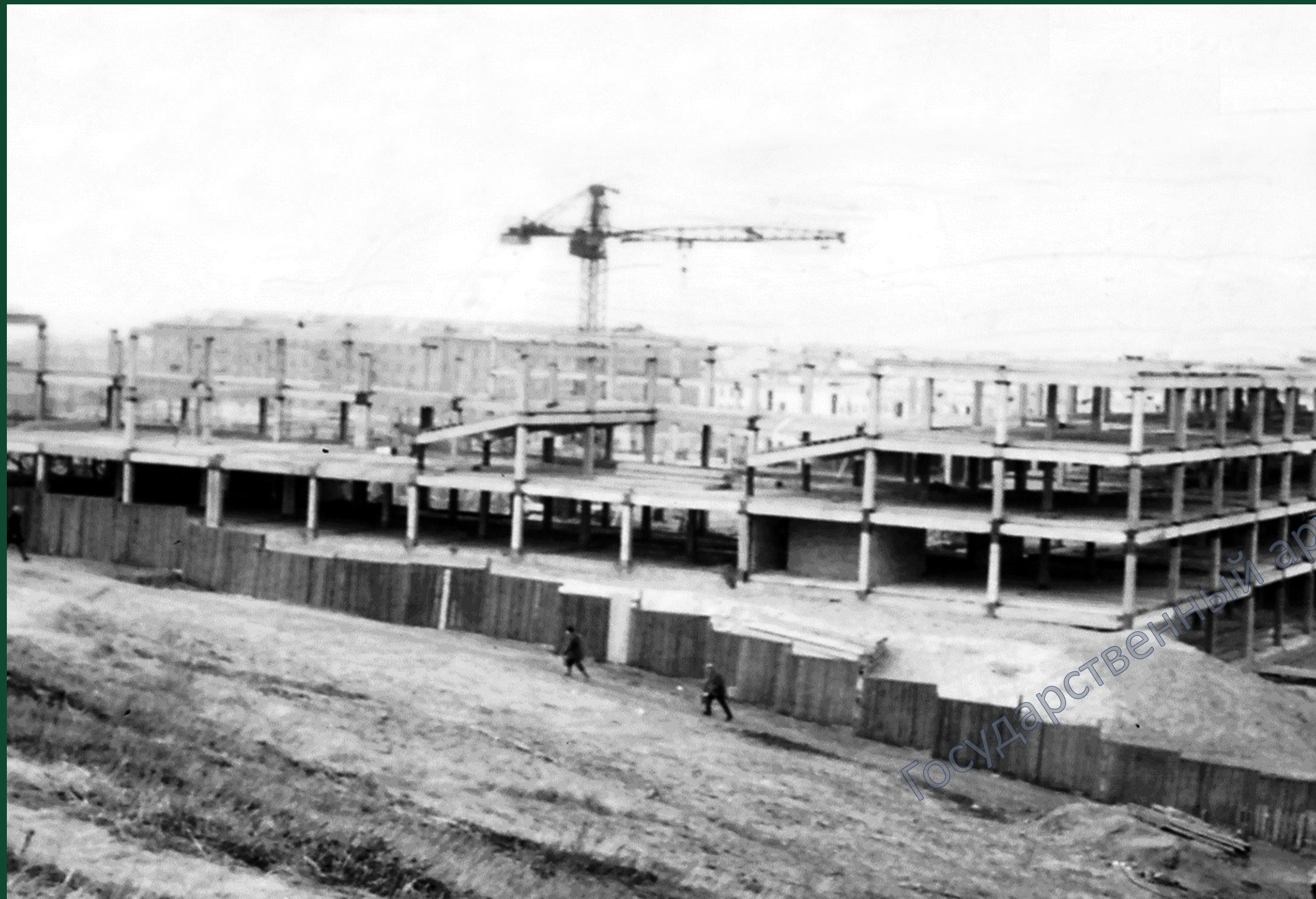
Строительство здания Института культуры на ул. Терешковой. г. Улан-Удэ, 1963 г. Фотофонд ГАРБ
